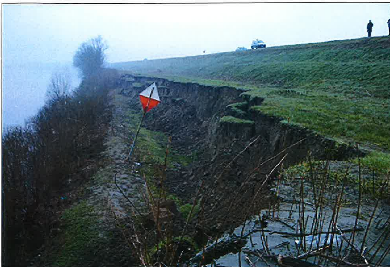
Fig. 2 – Frodo di Guarda Veneta - Evento franoso di scivolamento in sinistra idraulica di Po tra stanti 354-355 – Gennaio 2003
