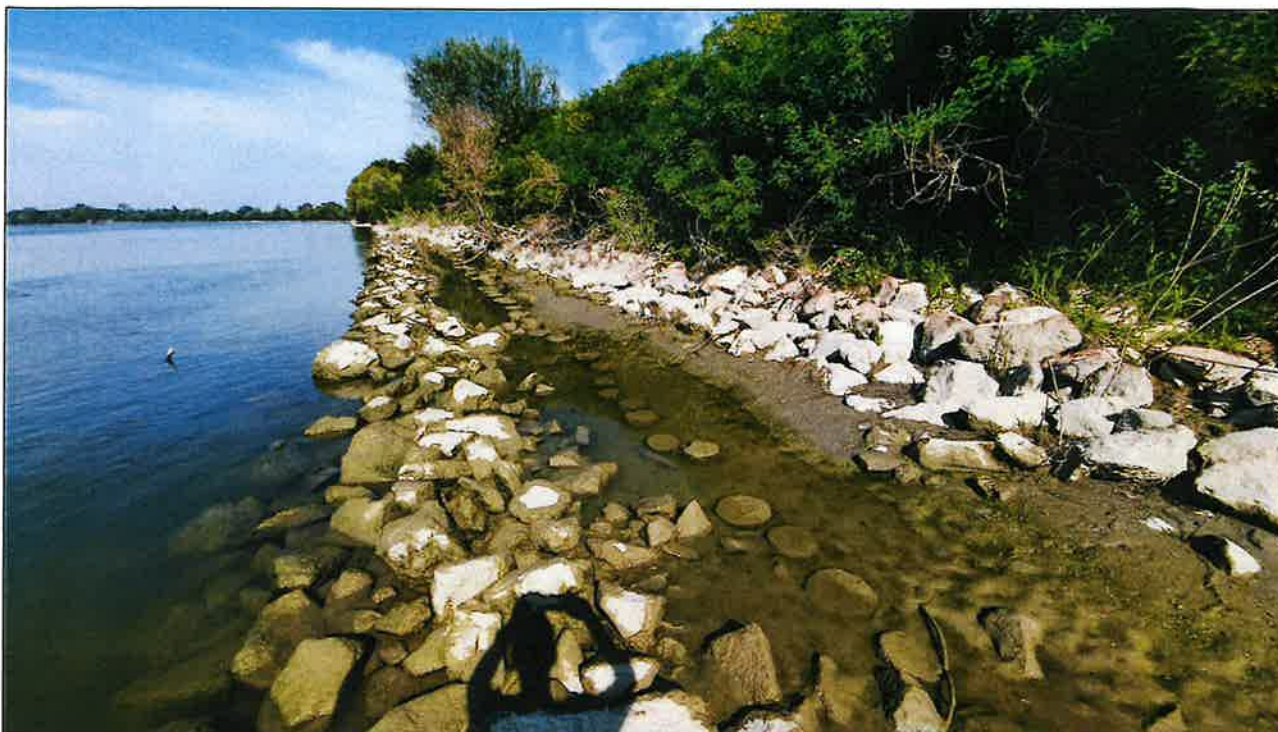
Fig. 5 – Frodo di Guardo Veneta - sinistra idraulica di Po tra stanti 354-355 – foto del 14/08/2025 – tratto d'intervento 1 (parte di monte) - in evidenza la testa scoperta della doppia palificata realizzata nell'anno 2003.
